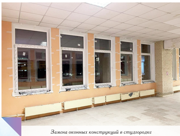
Ремонт жилых блоков в студгородке
