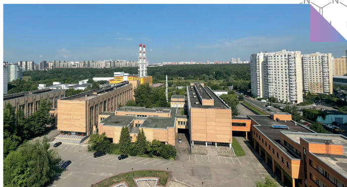
Идет капитальный ремонт кровли двух корпусов Тушинского комплекса
